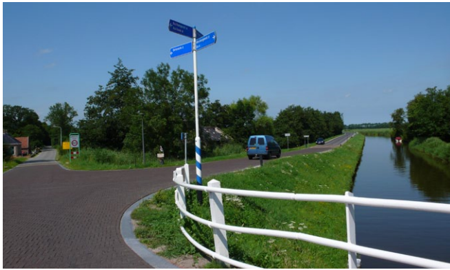
Geschwindigkeitsdämpfend ausgebauter Kanaluferstraße, „Stroobossertrekweg“ in Friesland (Niederlande)
