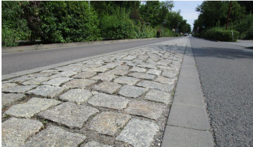
Gepflasterter Mittelstreifen aus Granit. Bildquelle: Tobias Klein
