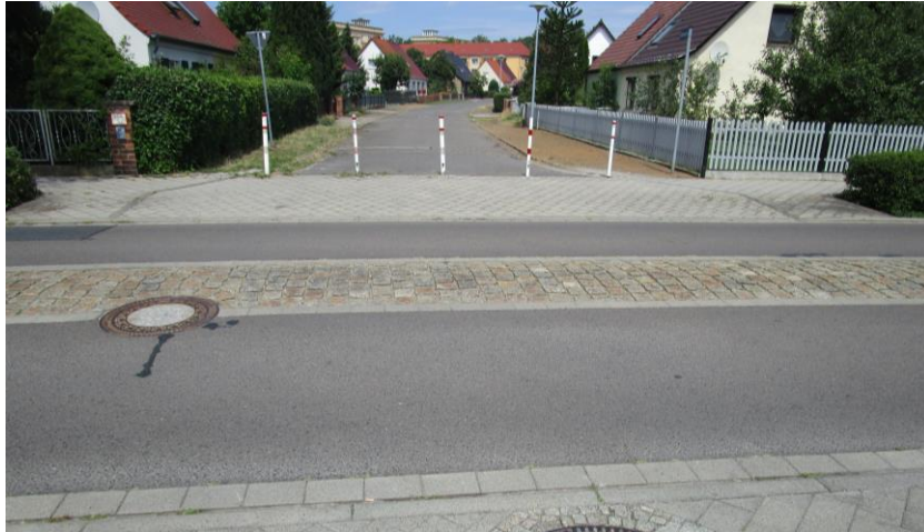
Die Nebenstraßen sind zum Teil mit Pollern von der Fahrradstraße getrennt. Bildquelle: Tobias Klein
