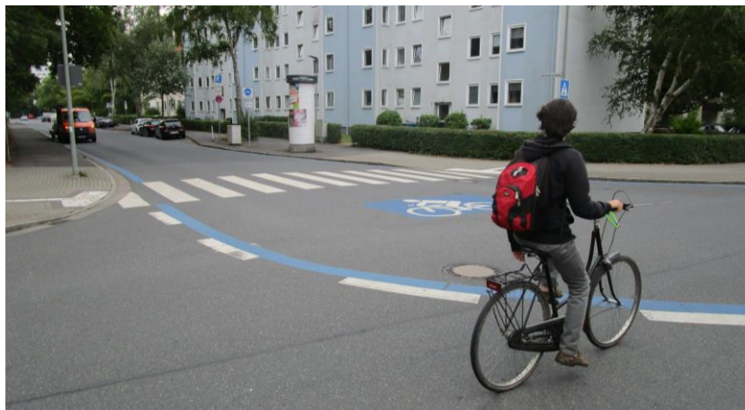
Blauer Breitstrich im Bereich des eRadschnellweges, der auch gleichzeitig die Vorfahrtsstraße verdeutlicht.
