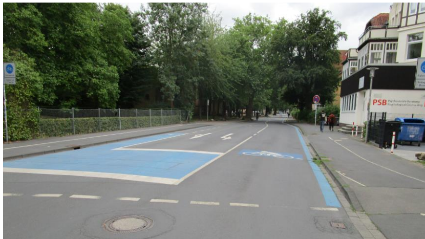
Aufgeweiteter Radaufstellstreifen (ARAS) am Knoten Goßlerstraße/Kreuzberg ring. Bildquelle: Tobias Klein
