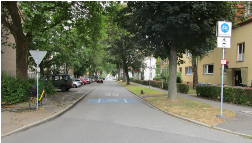
Flächenmarkierung und Tempo-30-Markierung am Beginn der Elbinger Straße.
