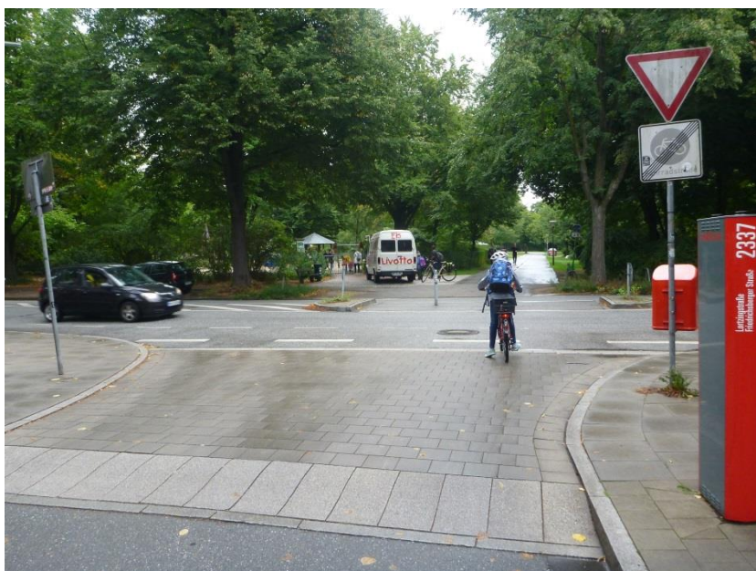
Aufpflasterung Anfangs-/Endpunkt Fahrradstraße in der Lortzingstraße Bildquelle: Sebastian Bührmann
