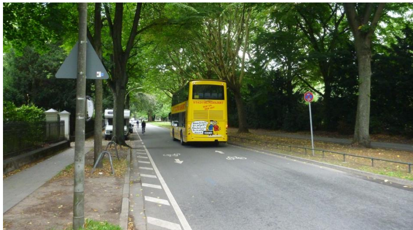
Einengung der Fahrgasse durch Schraffur im Harvestehuder Weg Bildquelle: Sebastian Bührmann
