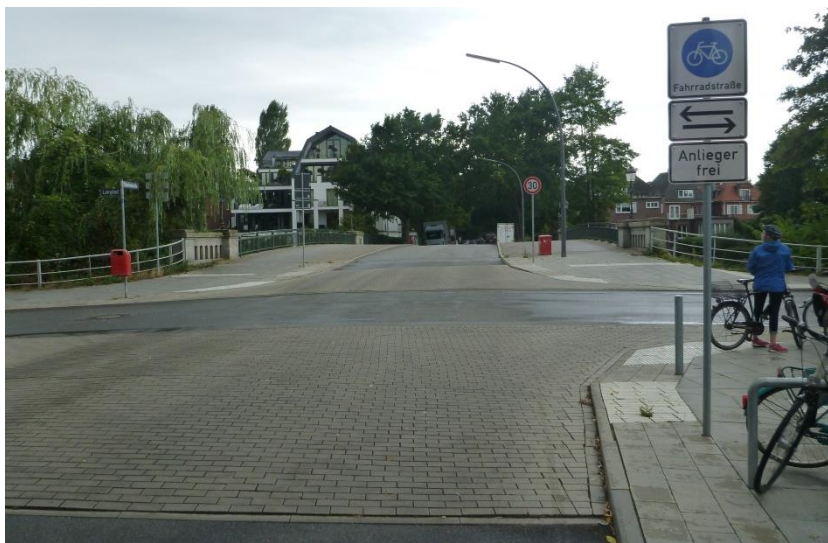
Gehwegüberfahrt an Einmündung zum Leinpfad Bildquelle: Sebastian Bührmann
