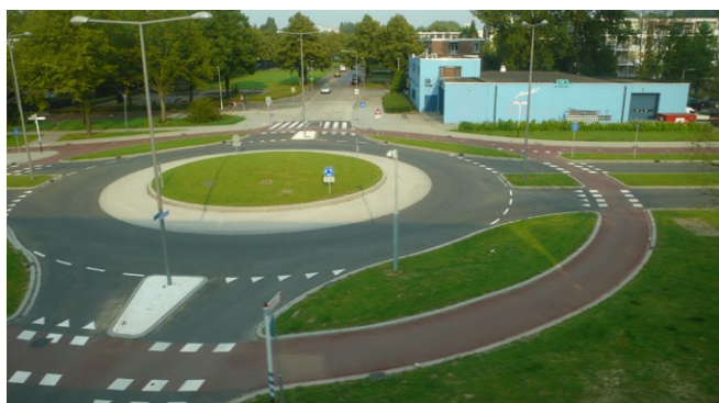
Kreisverkehr im Rotterdam (Niederlande) mit außen geführtem Radweg
